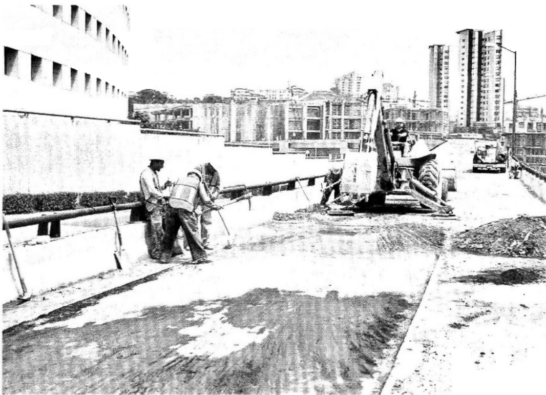
PARA LA FOTO. Obreros cerraron desde el sábado el puente que recién inauguró el Alcalde Alfredo del Mazo; aquí excavan sobre la cinta asfáltica para resanar los bordes que quedaron después de su construcción.
