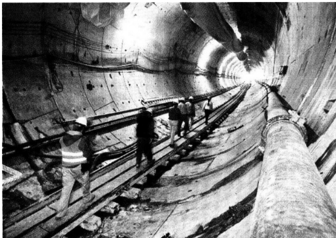
► La construcción del túnel lleva un avance de 271 metros de longitud.
