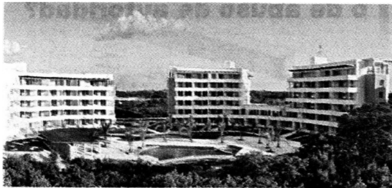
Siguen los problemas entre las empresas. (Foto: Archivo)
