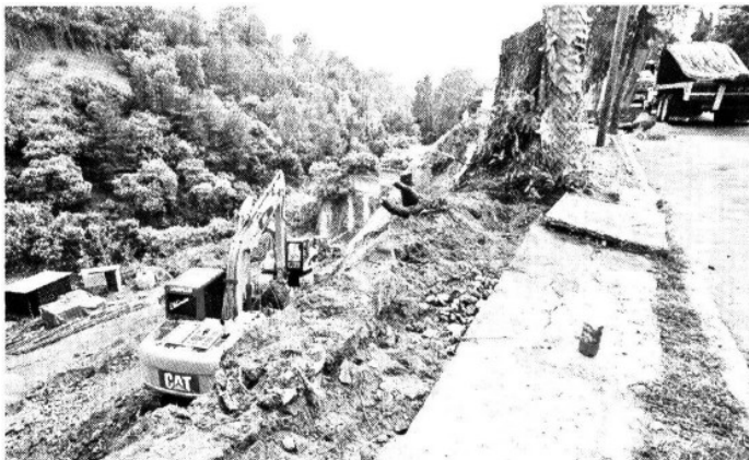
> Una obra en Fuente de Pirámides despertó el descontento de la comunidad, ya que el proyecto rebasa los 3 niveles permitidos.
