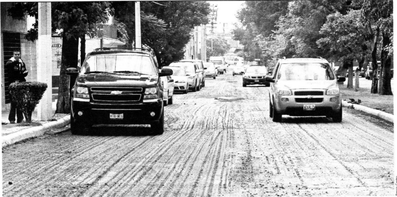
RAYADOS. En el Bulevar Santa Cruz, en el fraccionamiento Bulevares, ya comenzó el fresado de la carpeta asfáltica.
