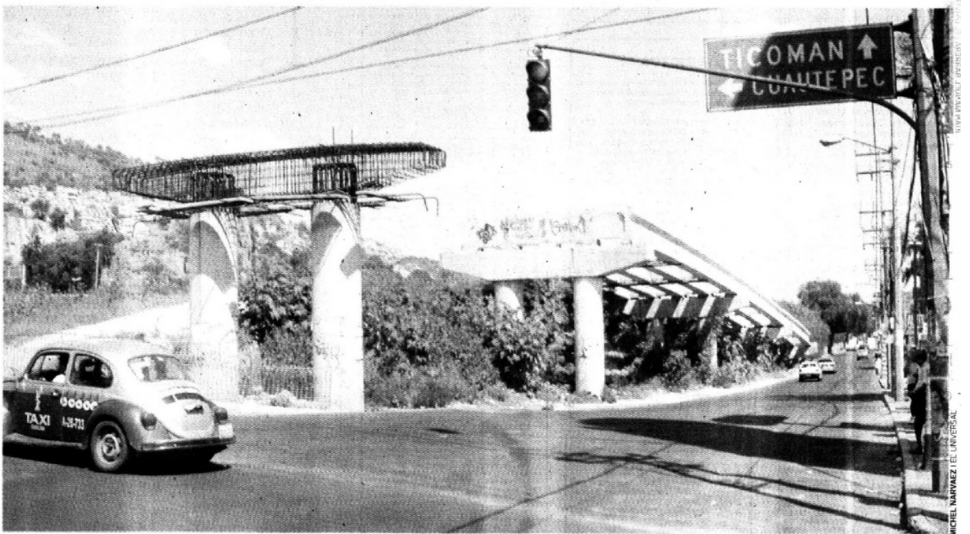
ABANDONO. Desde que se dañaron más de 900 casas al inundarse por un error en la construcción de un muro de contención, la vialidad está paralizada
