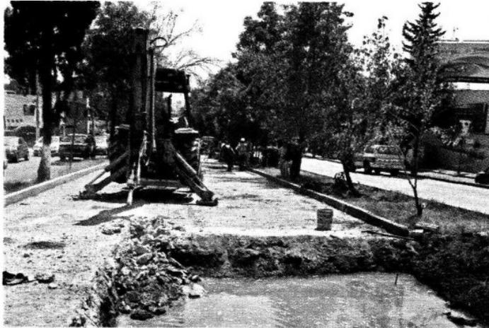
► Una de las máquinas rompió una tubería y ocasionó una fuga de agua.
