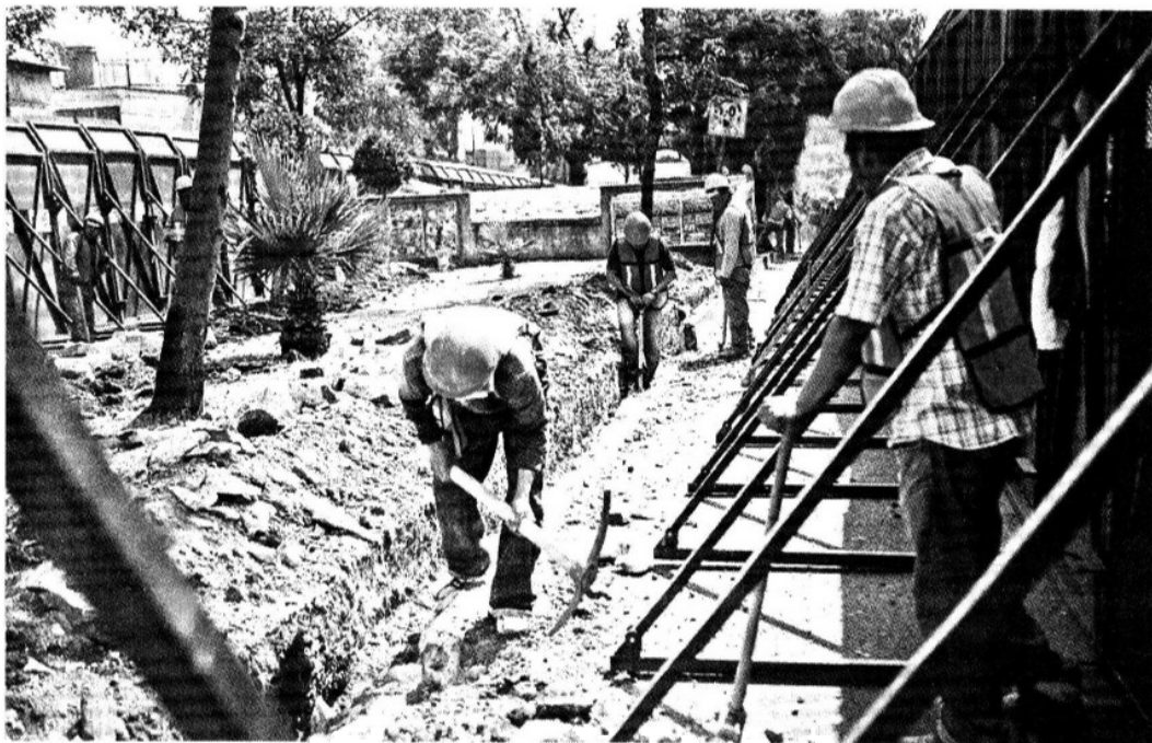
► Las vallas metálicas protegen la actividad en unos 50 metros del camellón de la Avenida Luis Cabrera.
