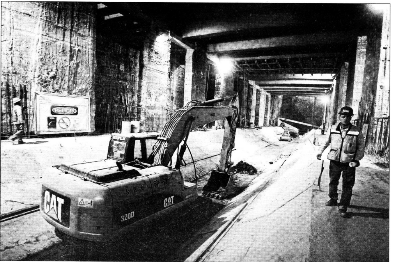
Aspecto de los trabajos subterráneos de la línea 12 del Metro, que correrá de Mixcoac a Tláhuac ■ Foto Alfredo Domínguez
