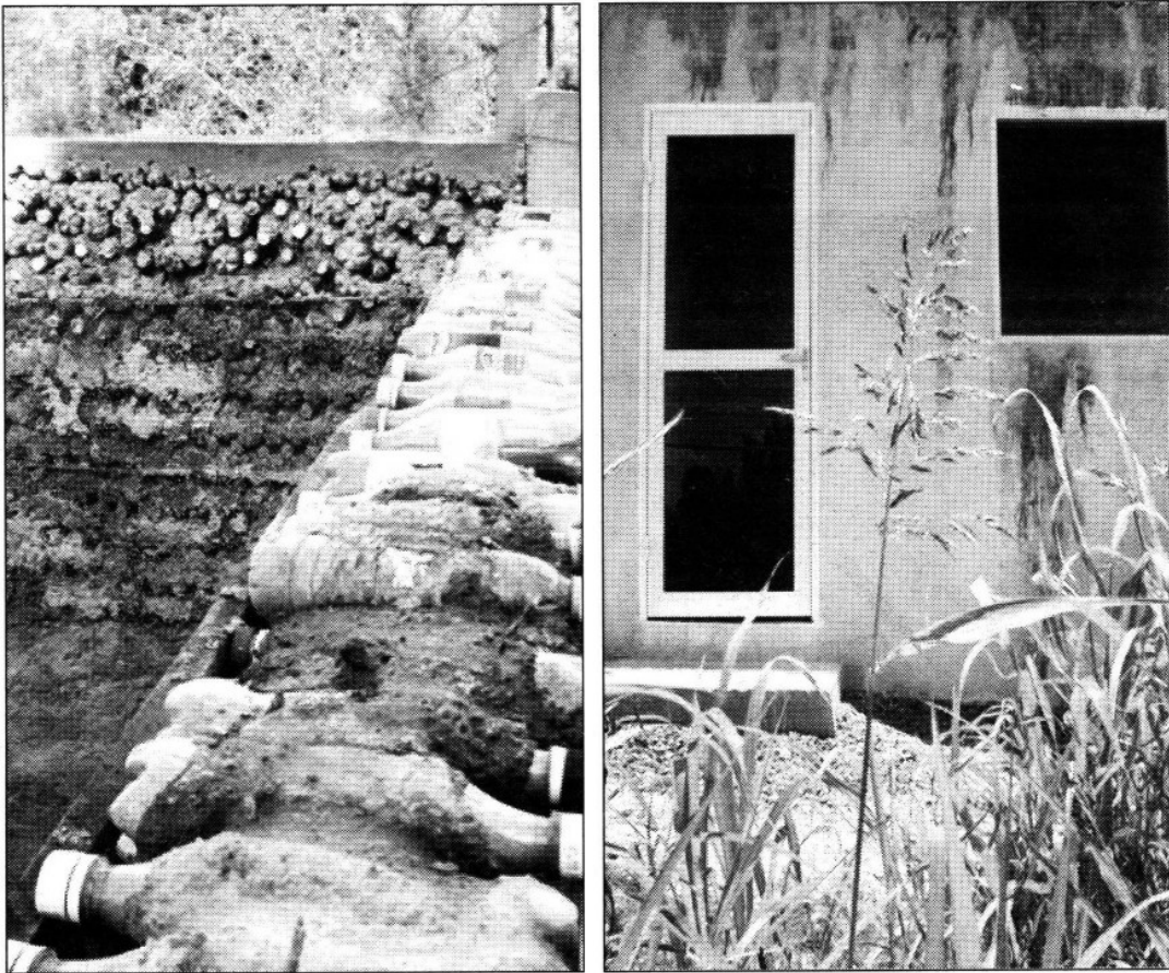
Proceso de construcción de una casa, que se muestra a la derecha ya terminada ■ Fotos Agencia Conacyt
