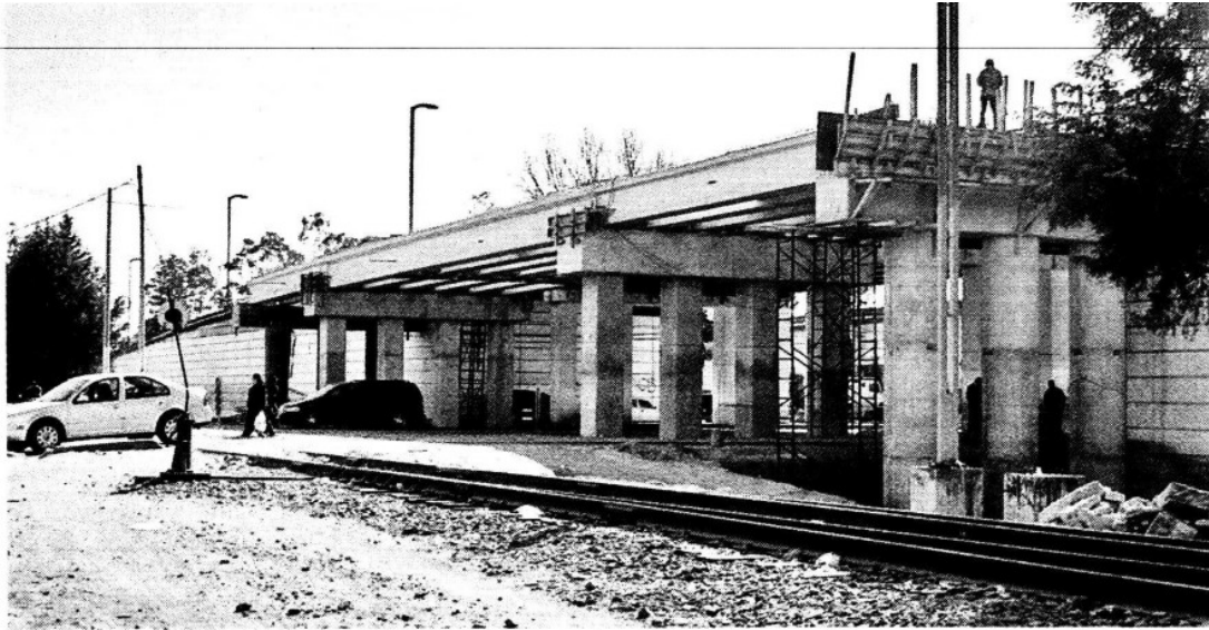
> La parte más avanzada está en Av. Tecnológico, en el sentido de México a Toluca; el puente ya está hecho.
