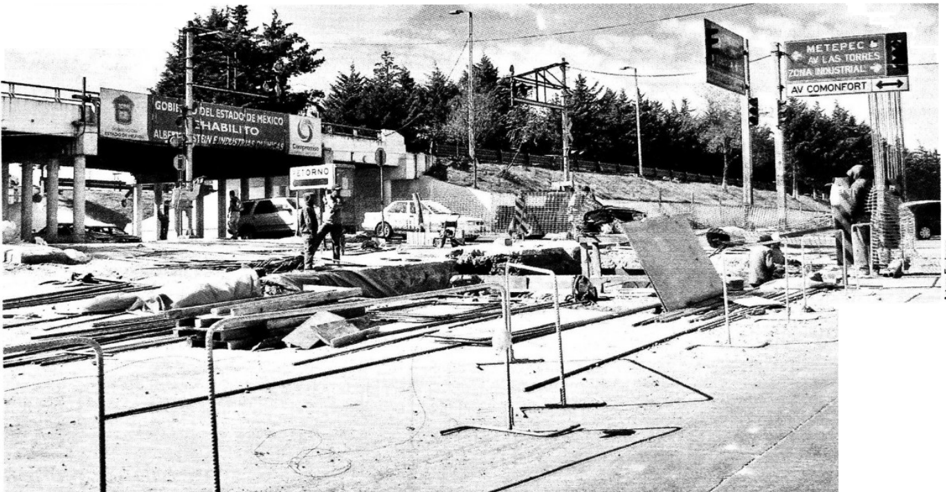
POR ARRIBA. En Avenida Comonfort, en el sentido de México a Toluca, se concentra la mayor cantidad de trabajo; aún se construyen los cimientos y las columnas que sostendrán el puente.
