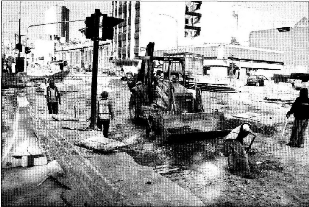
Otro frente de obra es el de la línea 3 del Metrobús, que correrá de Etiopía a Tizayuca, el cual, se anunció, será inaugurado la semana próxima. En la imagen, en la avenida Balderas ■ Foto María Meléndrez
