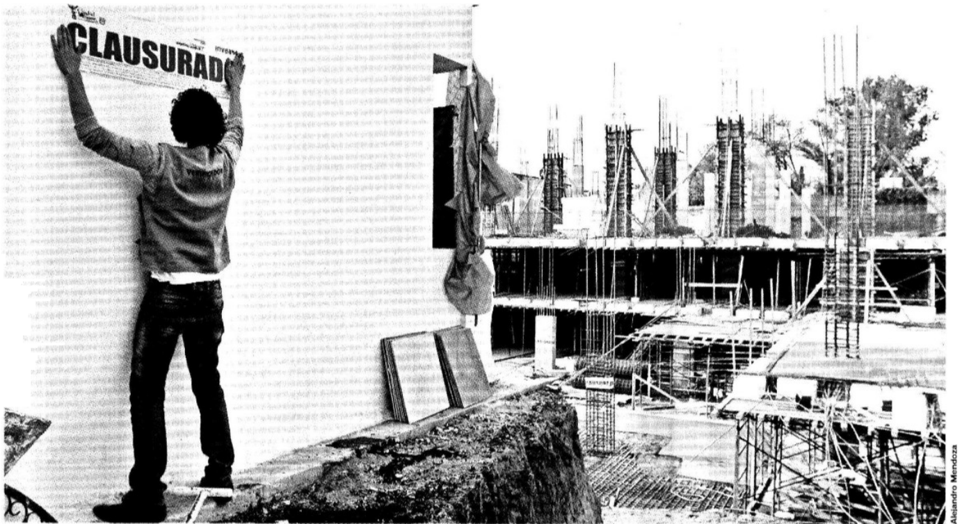
POR LA FUERZA. Personal del Instituto de Verificación Administrativa del DF clausuró la construcción ubicada en Avenida San Jerónimo 819, para lo cual fue necesaria la intervención de policías, debido a que los responsables de la obra habían negado el acceso de los verificadores al lugar.
