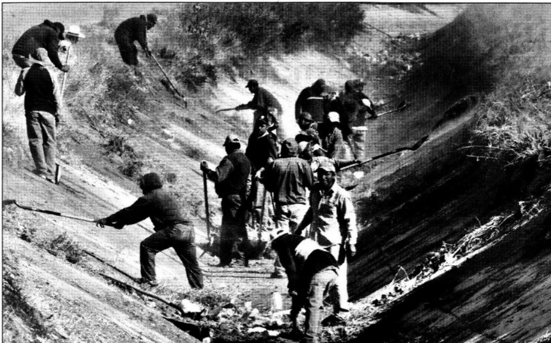
Antes del ciclo agrícola primavera-verano 2009, la Comisión Nacional del Agua realiza la limpieza de los canales de riego de la región lagunera de Coahuila y Durango, donde se hacen trabajos de desazolve, desmonte, deshierbe y desagüe de algunas zonas ■ Foto Notimex
