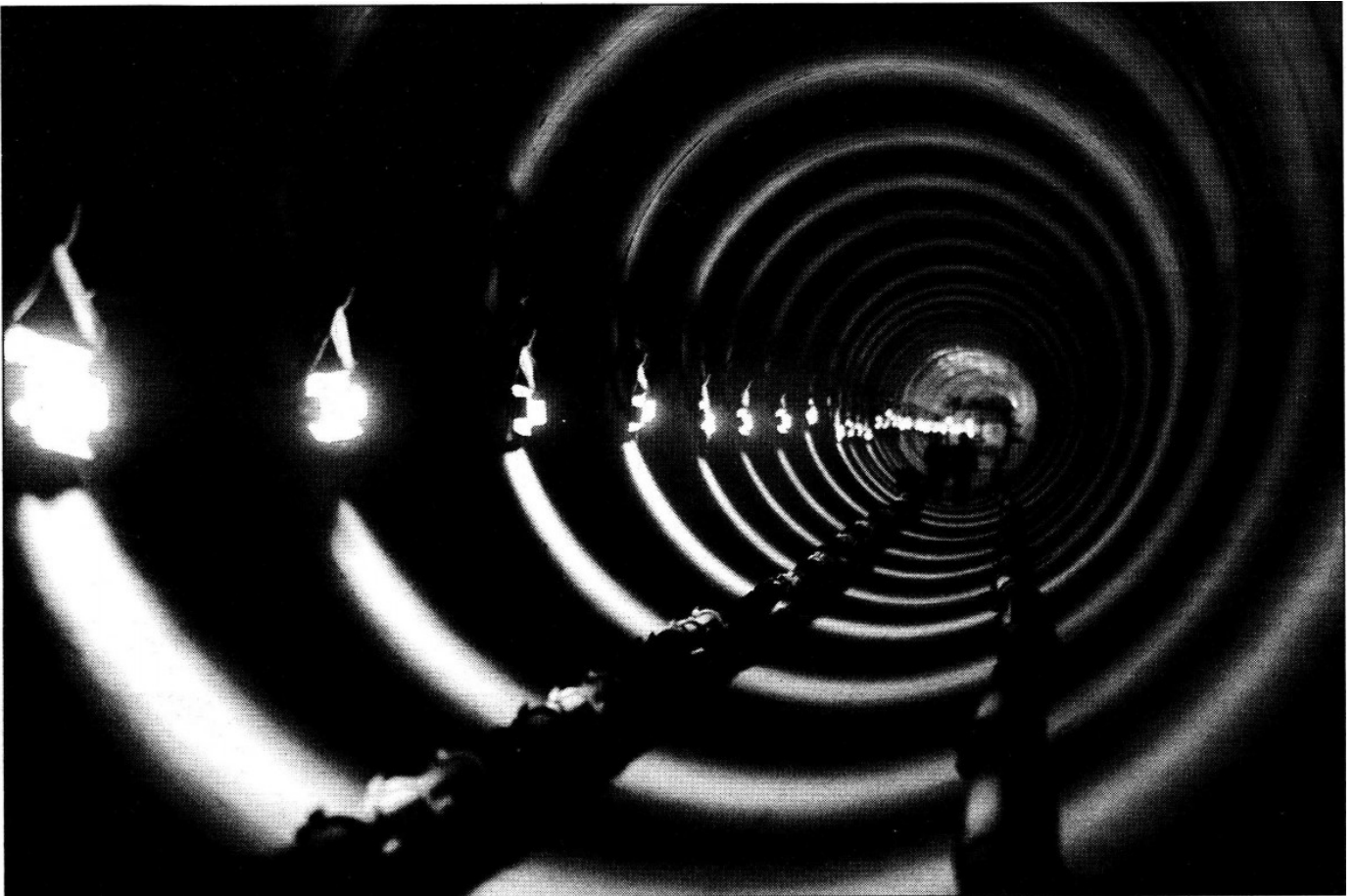
Túnel del Drenaje Profundo, en la zona de Martín Carrera, el cual recorrió ayer el jefe de Gobierno la capital, Marcelo Ebrard ■ Foto Carlos Cisneros
