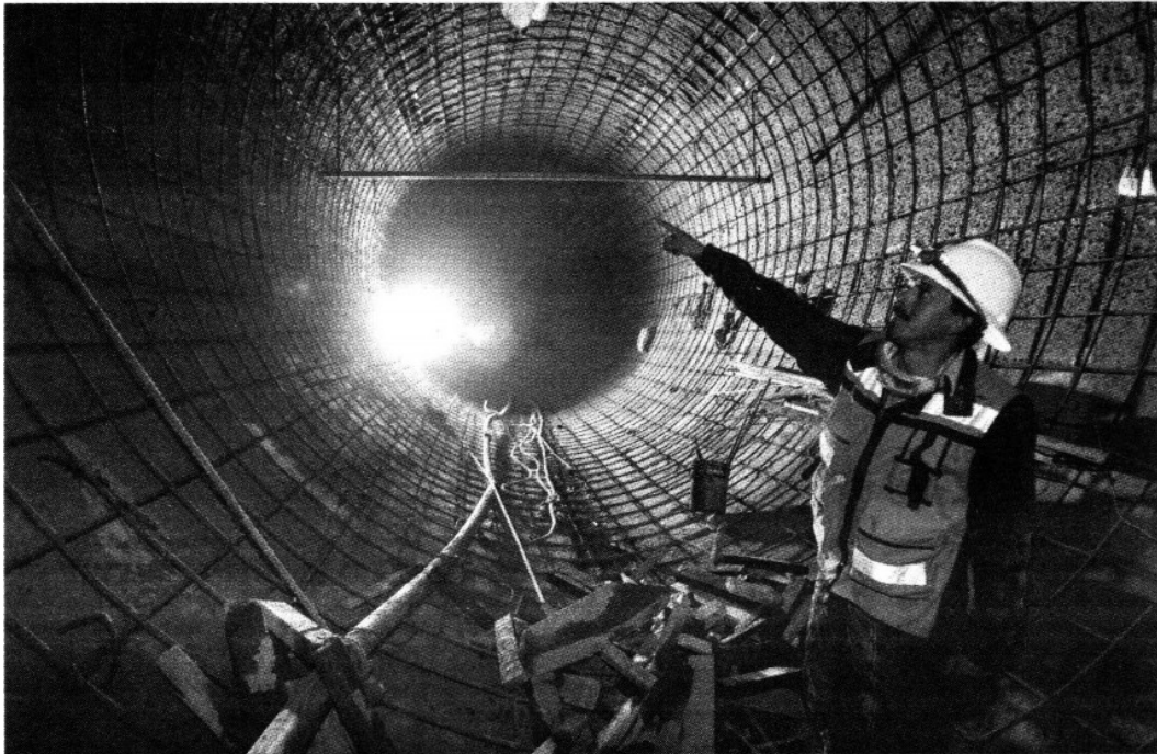
Los trabajos de rehabilitación del Drenaje Profundo terminarán a tiempo, el 15 de abril, antes de las lluvias, promete el Gobierno del Distrito Federal.
