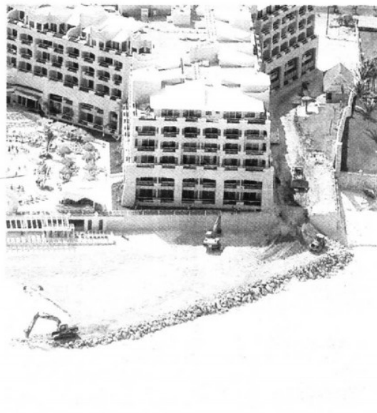
OBRAS de relleno y construcción de un espigón de piedra en playas del Hotel Gran Caribe Real, propiedad del empresario García Zalvidea
