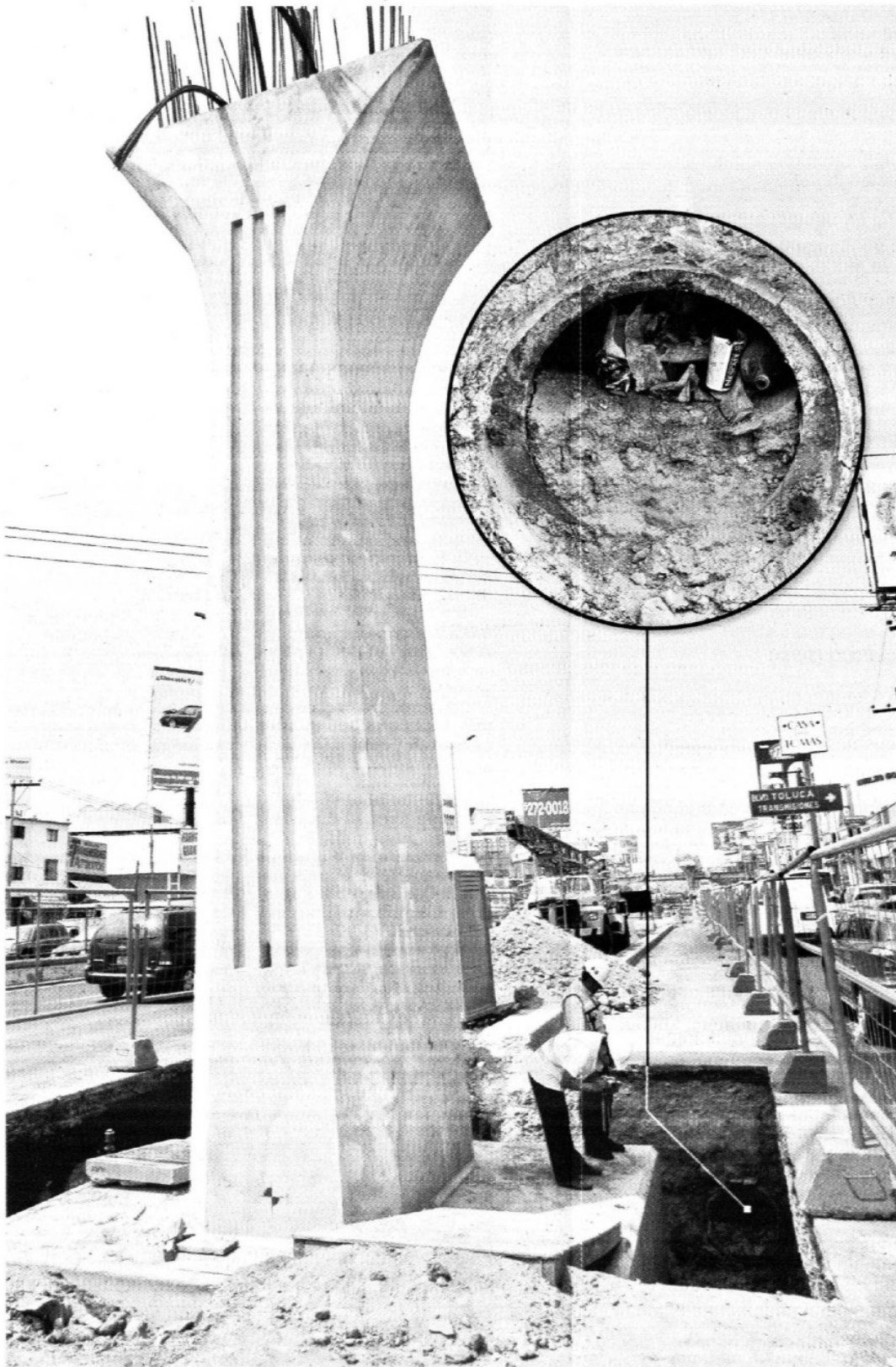
> El tubo dañado es de concreto simple, ahora se va a cambiar por polietileno de alta densidad.
