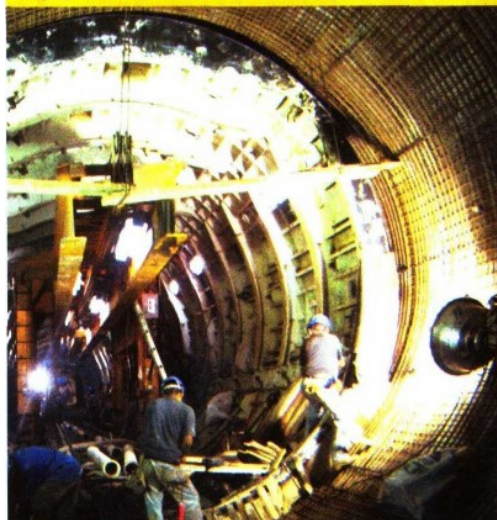
Por medios mecánicos se hace la entrada del túnel por donde pasará el escudo perforador.
