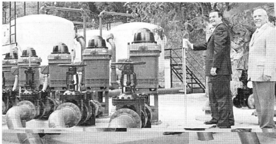
Marcelo Ebrard, al inaugurar la planta potabilizadora Magdalena Contreras. (Foto: Notimex)
