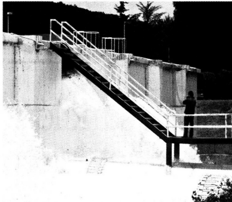
➤ En la planta Los Berros, del Sistema Cutzamala, se realiza la potabilización del vital líquido el cual llega al DF y área conurbada.
