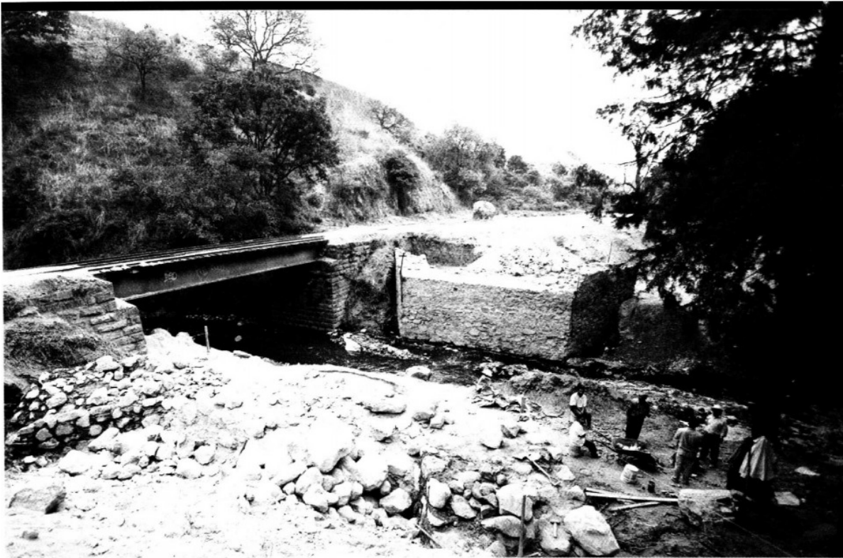
El puente que cruzará sobre Río Hondo corre paralelo a las vías ferroviarias de la ruta Naucalpan-Toluca, entre Lomas Country Club y Bosque Real; acusa empresa afectación al derecho de vía.
