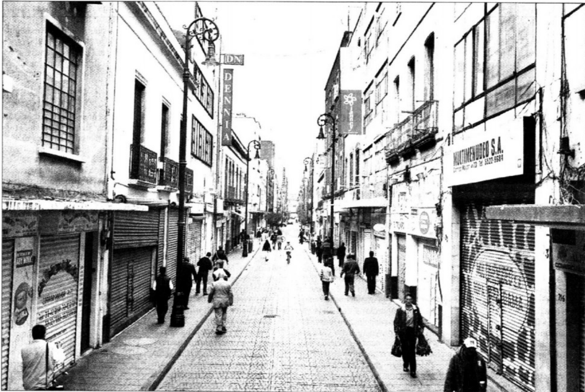
Con una inversión de 241 millones de pesos, ayer quedó concluido el rescate de la plaza Manzanares y ocho calles aledañas, las cuales fueron entregadas a la comunidad capitalina por el jefe de Gobierno, Marcelo Ebrard. Fachadas de piedra y cantera, pavimentos que semejan caminos empedrados y postes de alumbrado que dan a la zona un sabor de principios del siglo pasado son el nuevo paisaje urbano en la parte oriente; destaca el remozamiento de una capilla del siglo XVIII ■ Foto Roberto García Ortiz
