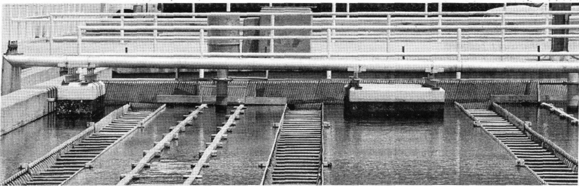
La Comisión Nacional del Agua concluyó ayer la reparación de la tubería de 99 pulgadas de la línea 2 del Sistema Cutzamala, por lo que dio por hecho que alrededor de las 10:00 horas empezó a normalizarse el servicio de entrega de agua al Valle de México. (Foto: Braulio tenorio)
