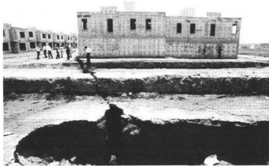
Habitantes de unas 50 viviendas de la Unidad Habitacional Villas de San Martín serán reubicados a un lugar más seguro luego de la grieta que se abrió en la zona.
