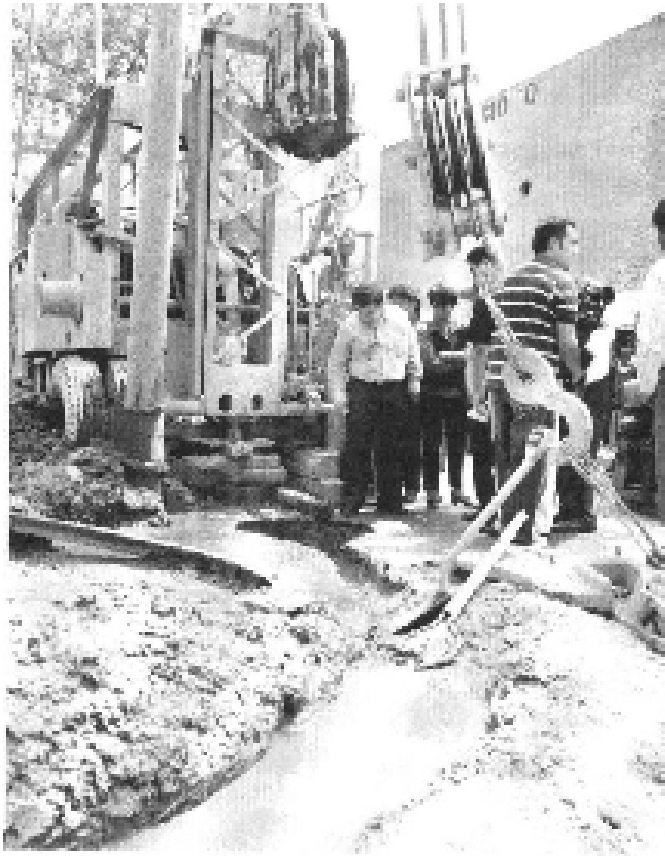
APROVECHAMIENTO. La construcción de cada pozo cuesta unos cinco millones de pesos, calculó el delegado de Iztapalapa
