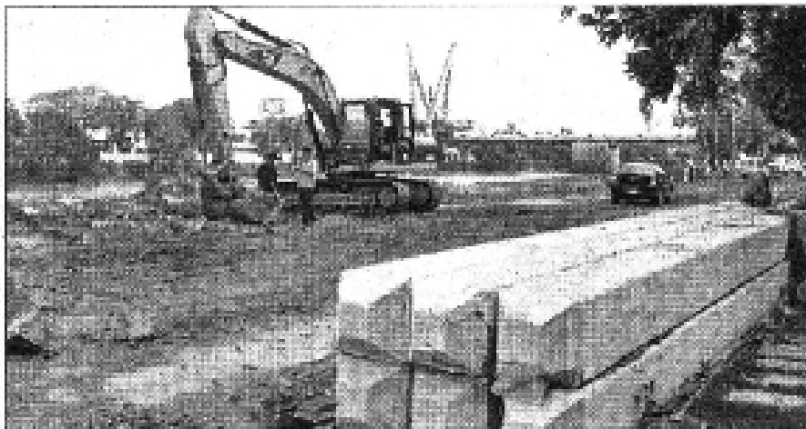
1) LOS PILOTES fueron prefabricados para las obras de reconstrucción de los malecones.
