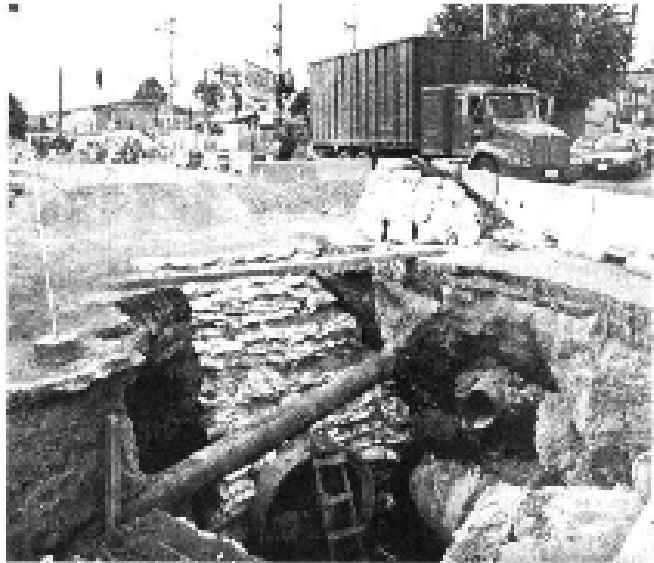
EXCAVACIÓN. 500 mil personas se quedaron sin agua por las obras inducidas de la línea 12 que se realizan en avenida Tláhuac
