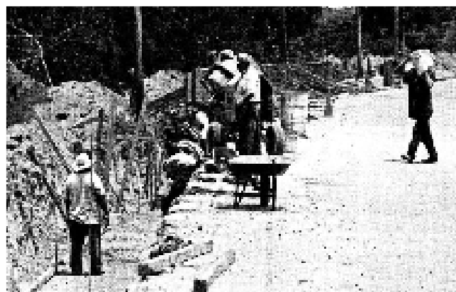
A lo largo del río Viejo Mezcalapa se está construyendo un borde a la orilla de la carretera el cual divide las propiedades de algunos vecinos.
