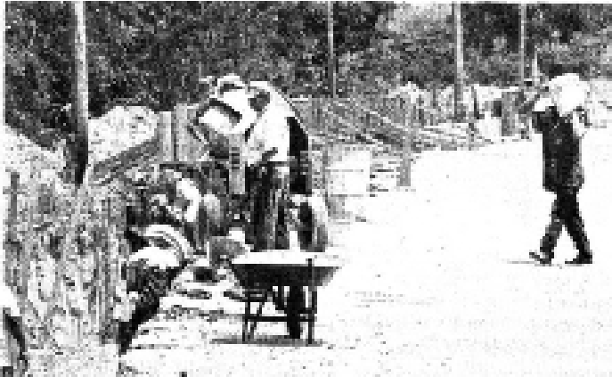
A lo largo del río Viejo Mezcalapa se construye un borde a la orilla de la carretera, que según los vecinos, les corta el acceso a sus propiedades.
