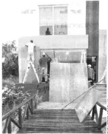
PREVENCIÓN. Habitantes de San José del Cabo protegen los ventanales de sus hogares
