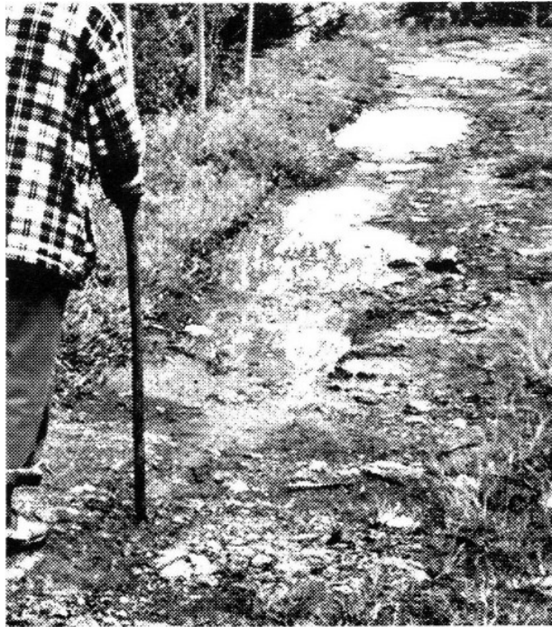
Aguas estancadas, riesgo para la salud.
