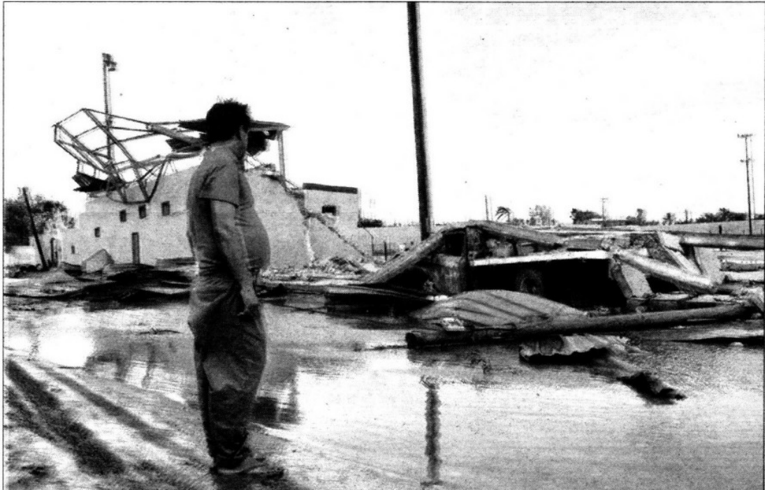
RUINAS. Ciudad Constitución, en el municipio de Comondú, fue también severamente afectada por el huracán.
