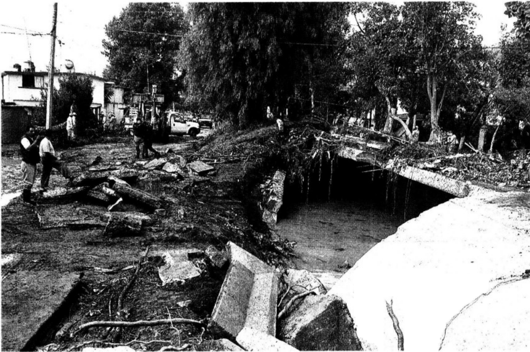
► El tubo que colapsó fue construido desde hace 40 años con el objetivo de evacuar hacia el estado de Hidalgo las aguas pluviales que caen en las montañas del poniente de la Ciudad.
