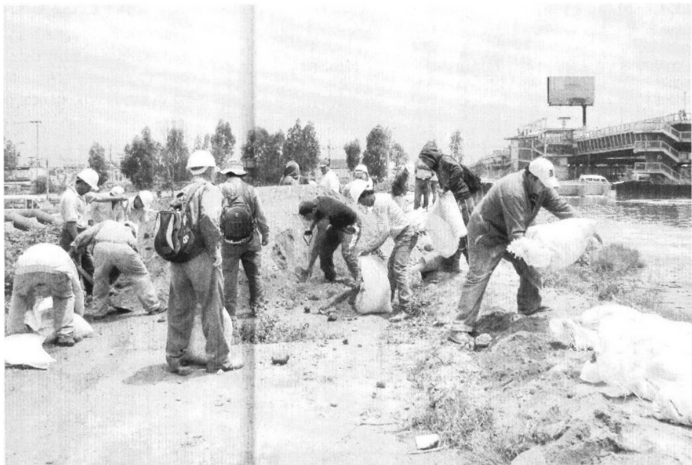
DIQUE. Los costales se colocaron entre la avenida Central y la colonia Las Vegas Xalostoc
