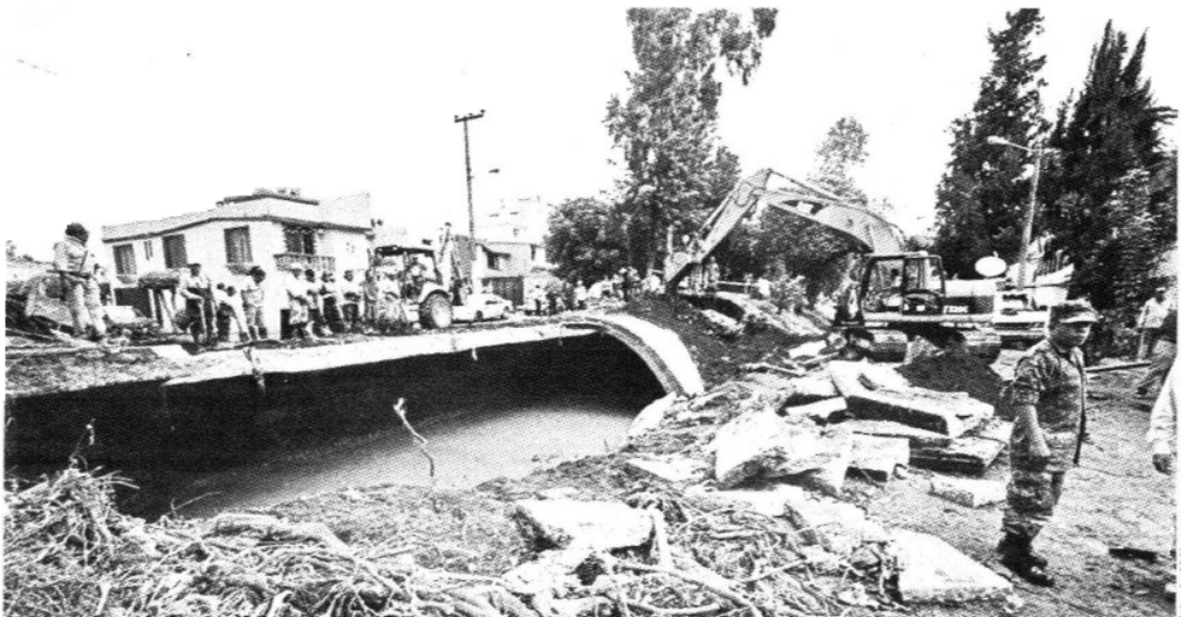
El Emisor Poniente se reventó en la zona de Valle Dorado por la fuerte lluvia que cayó durante hora y media y que generó un afluente de 100 mil litros. Este ducto de 4 metros de diámetro puede distribuir 80 mil litros por segundo.
