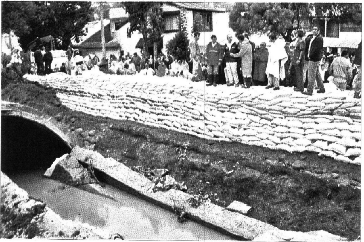
» LOS TESTIGOS de la ruptura del emisor señalan que minutos antes de que estallara a causa de la fuerte presión del agua, comenzó a vibrar la zona del ducto siniestrado.
