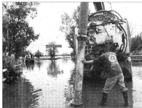
>> A MARCHAS forzadas se realizan los trabajos de desazolve y nivelación del Periférico Oriente.
