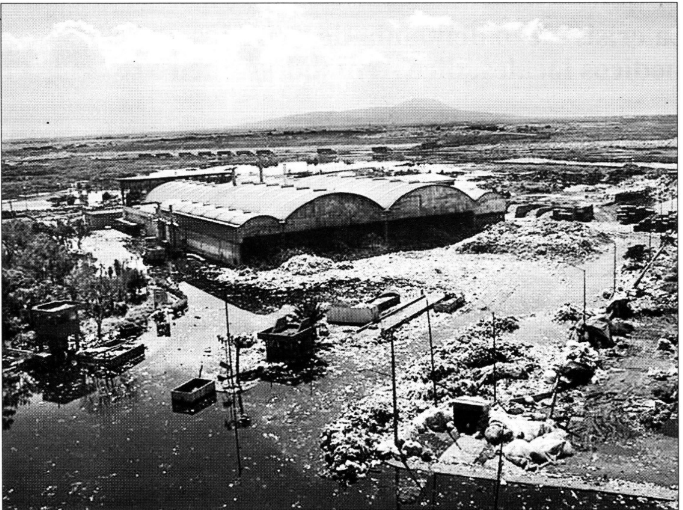
Imagen proporcionada por la Conagua en la que se aprecia la inundación en una planta clasificadora ubicada en el Bordo Poniente
