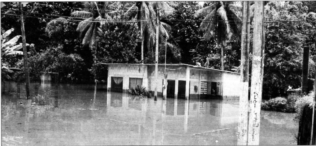
El río Valle Nacional se desbordó la madrugada de ayer en el municipio de San Juan Bautista, en la de la cuenca del Papaloapan, y provocó inundaciones en por lo menos unas 800 viviendas ■ Foto Octavio Vélez
