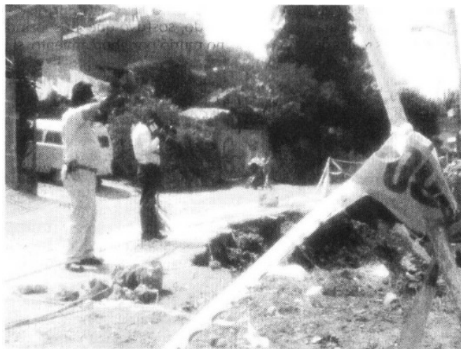
PELIGRO. Una de las avenidas afectadas por los deslaves
