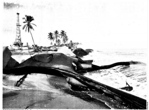
CONSECUENCIAS. Pemex ha instalado bloques de concreto y geotubos (barreras rellenas de arena) para evitar que el agua de mar alcance los pozos petroleros en la zona de Tizón.
