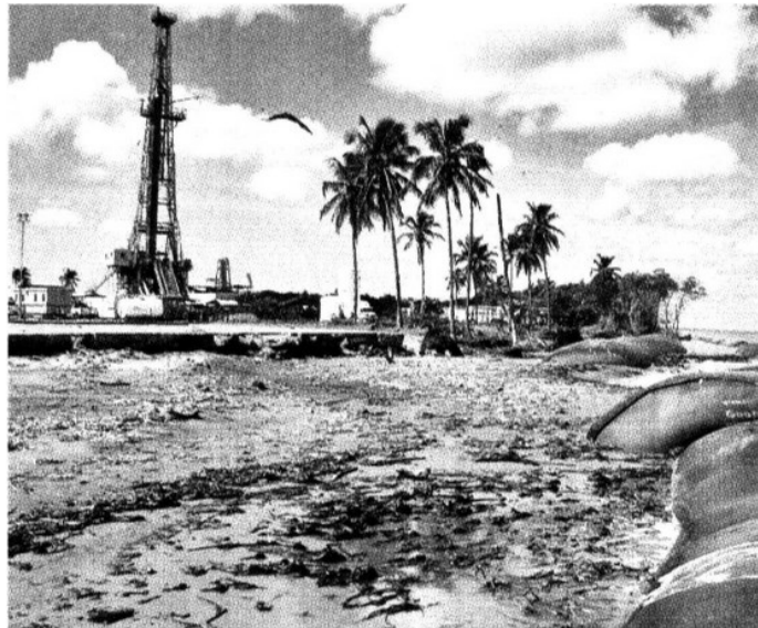
> Pemex ha colocado geotubos debido a la erosión en la playa del Municipio de Centla, para proteger sus instalaciones.
