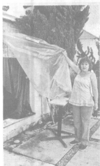
SIN RESPUESTA. Guadalupe Morales sigue esperando a las cuadrillas que repararían su casa, ubicada en la calle de Medellín.
