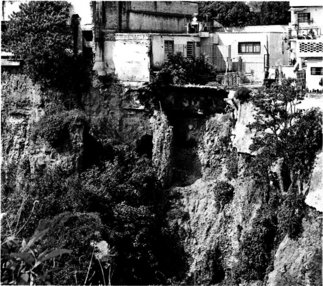
► En Santa Rita se acumulan unas 500 toneladas de desechos, pero también se asientan 64 familias que corren riesgos ante posibles deslaves y taludes.
