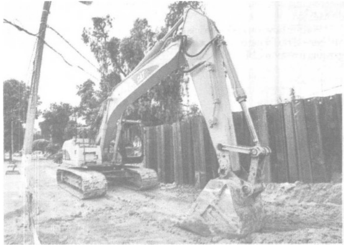
Los trabajadores retiraron parte de la costalera que sirvió de muralla para contener otro posible desbordamiento; ayer metieron tierra nueva.
