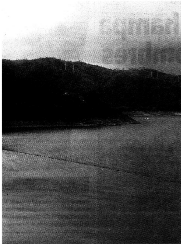
La presa en jurisdicción de la dependencia federal
