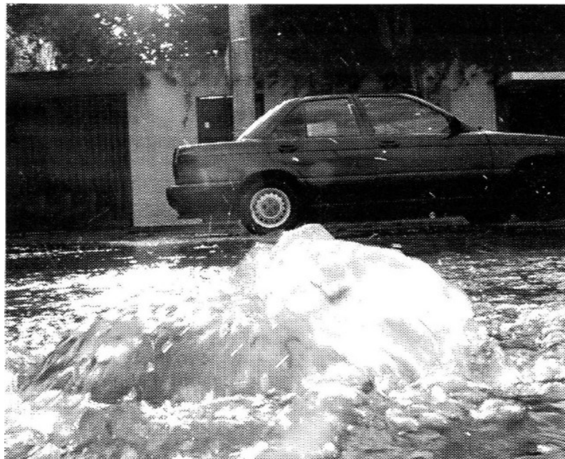
Denuncian tuberías fracturadas por hundimientos.
