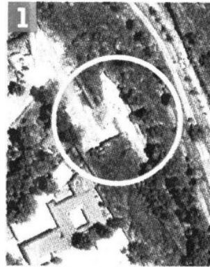
> El entubamiento del río San Javier fue realizado hace 9 años. El entubamiento pasa por 23 colonias.
